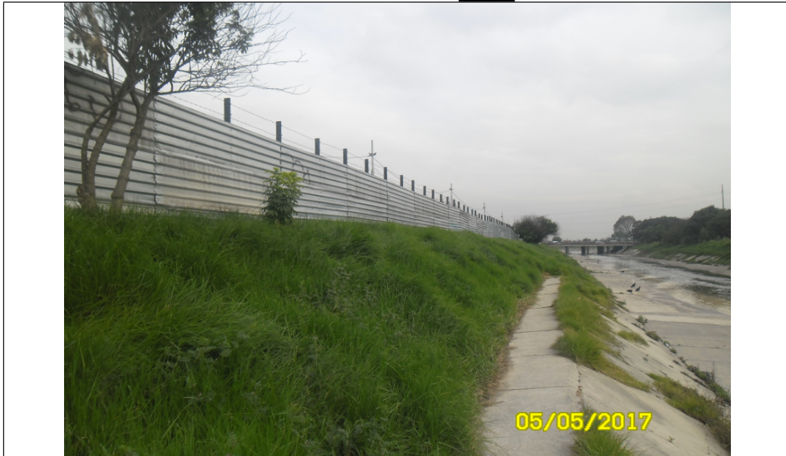
Fotografía 2. Cerramiento hacia el Canal del proyecto constrictivo Centro comercial el Edén.
