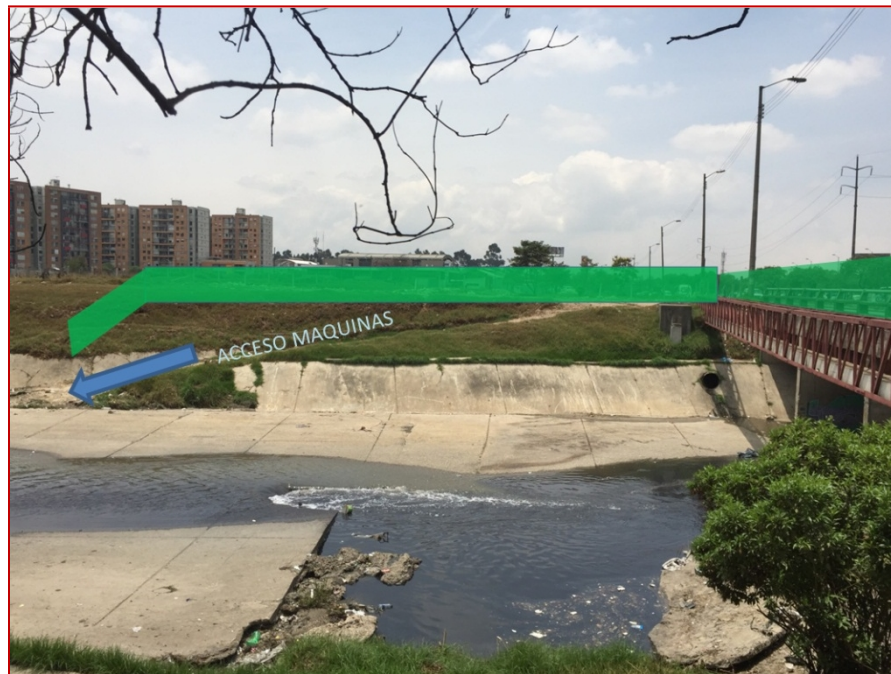
Figura 2. Cerramiento zona costado Sur Canal del Río Fucha
