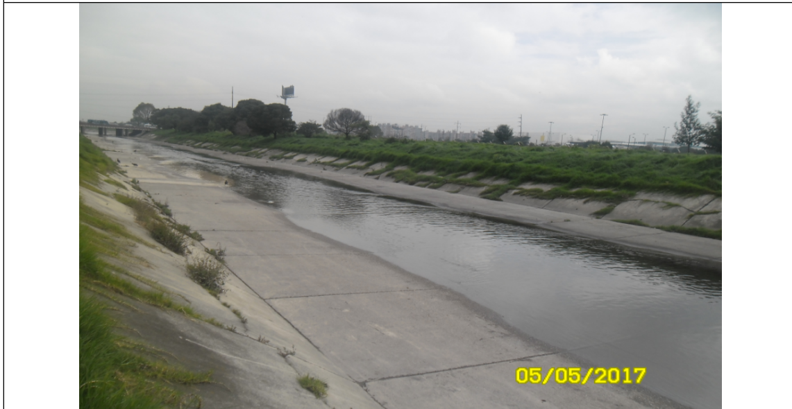
Fotografía 3. Panorama general de las condiciones del area a intervenir
