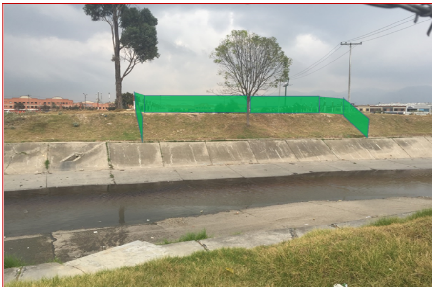
Figura 4. Cerramiento zona costado norte Canal del Río Fucha
